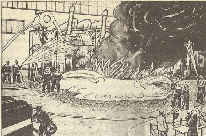
Ликвидацию горения внутри трансформаторов и другого маслонаполненного электрооборудования осуществлять порошком, пеной низкой кратности или распыленной водой, подачу стволов осуществлять через отверстия шинопроводов, при этом избегать аварийного слива масла из трансформаторов.
